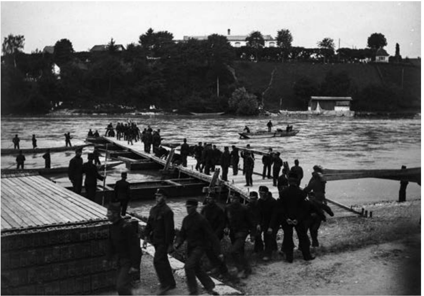
Früher: Pontoniere beim Bau einer Pontonbrücke im Geissenschachen Brugg um das Jahr 1900. Bildquelle: Stadtarchiv Baden
