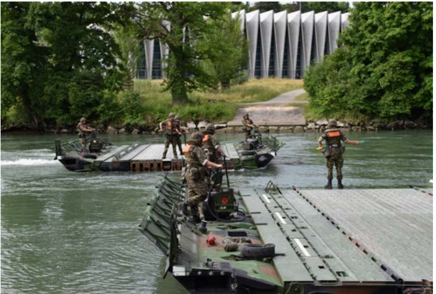
Heute: Pontoniere beim Bau einer Schwimmbrücke im Geissenschachen Brugg im Jahr 2017. Bildquelle: VBS/DDPS
